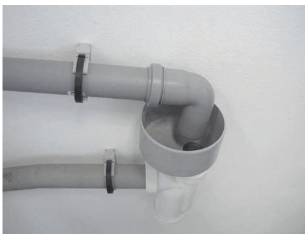
Bild IV.13: Schema Anschluss Abwasserleitung mit offenem Trichtersiphon
